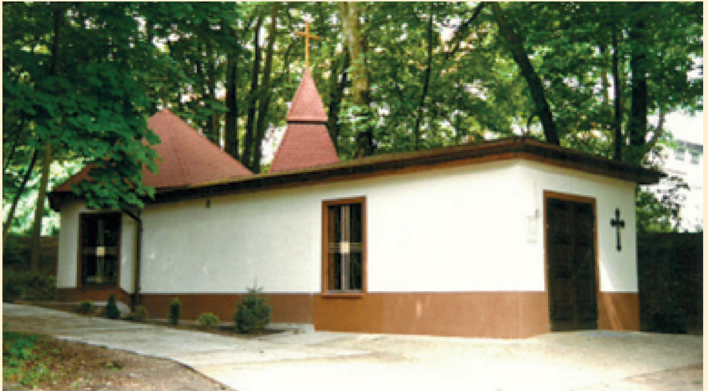
Kaplica w Ludwikowie przed remontem z płaskim dachem
