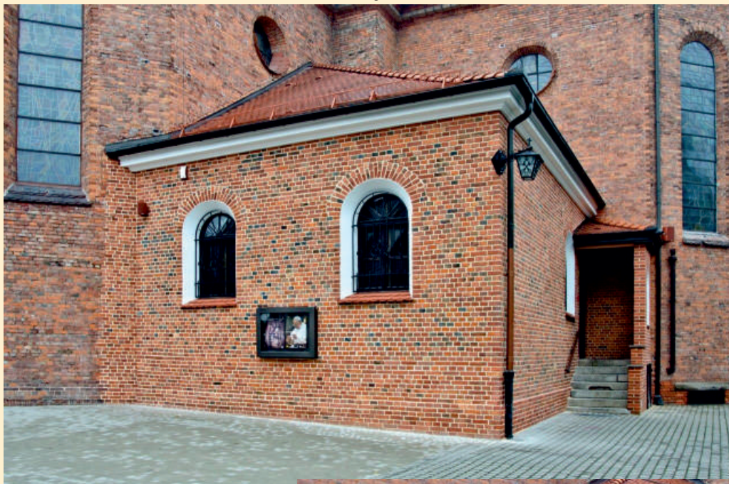
Zakrystia strona południowa (na łączeniu ścian zakrystii z transeptem widać zróżnicowaną fakturę cegły przed i po renowacji)
